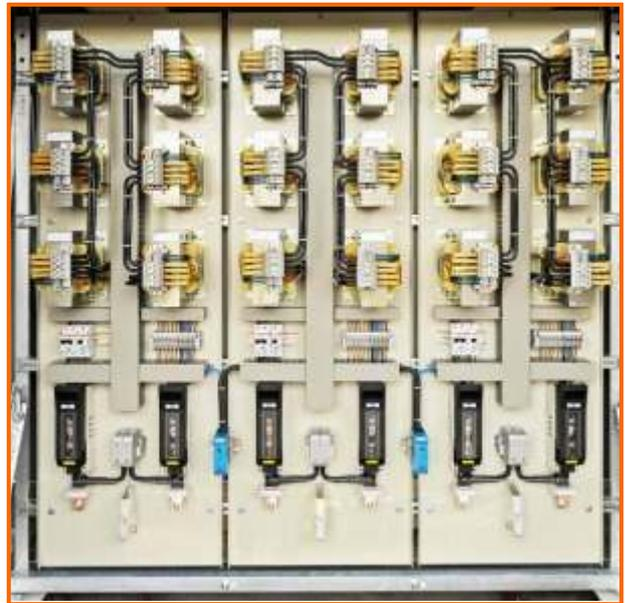
Der Netzregler für Fundamentaufstellung ist in einem doppelt tiefen Kabelverteilerschrank, geeignet zur Aufstellung auf einem Normsockel, eingebaut.
