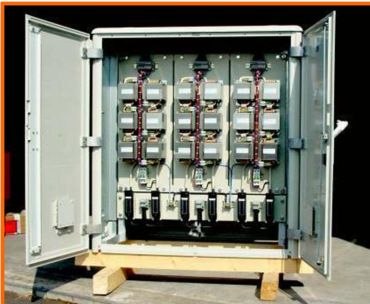
Links ist der für den Versand vorbereitete Netzregler. Er wird auf Holzbohlen montiert ausgeliefert. Dies erlaubt es leicht, mit einem Gabelstapler, den Netzregler zu transportieren.
