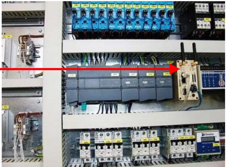
Optional können in den Netzregler GSM Router zur Fernabfrage der technischen Betriebsdaten eingebaut werden. Über das 104-er Protokoll lassen sich die Regelparameter des Netzreglers in den zulässigen Bereichen verändern.
